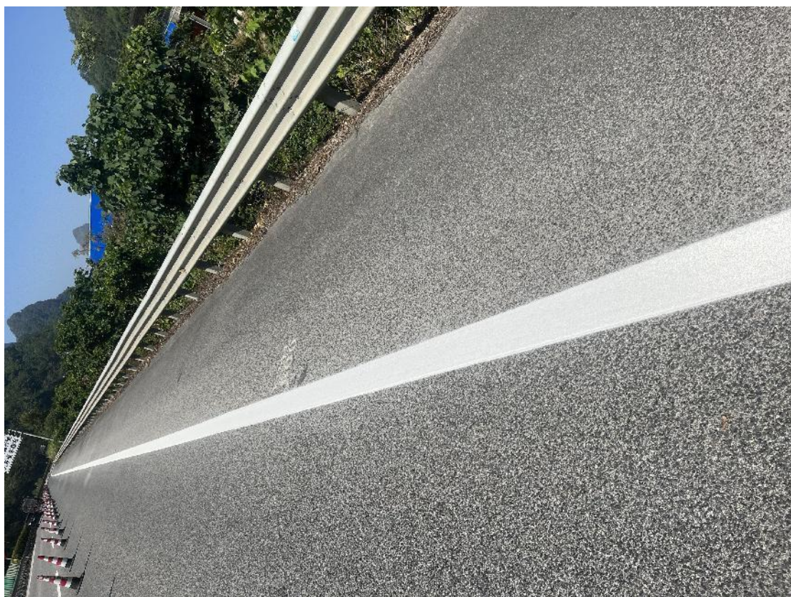
广西河池试验段喷涂标线
